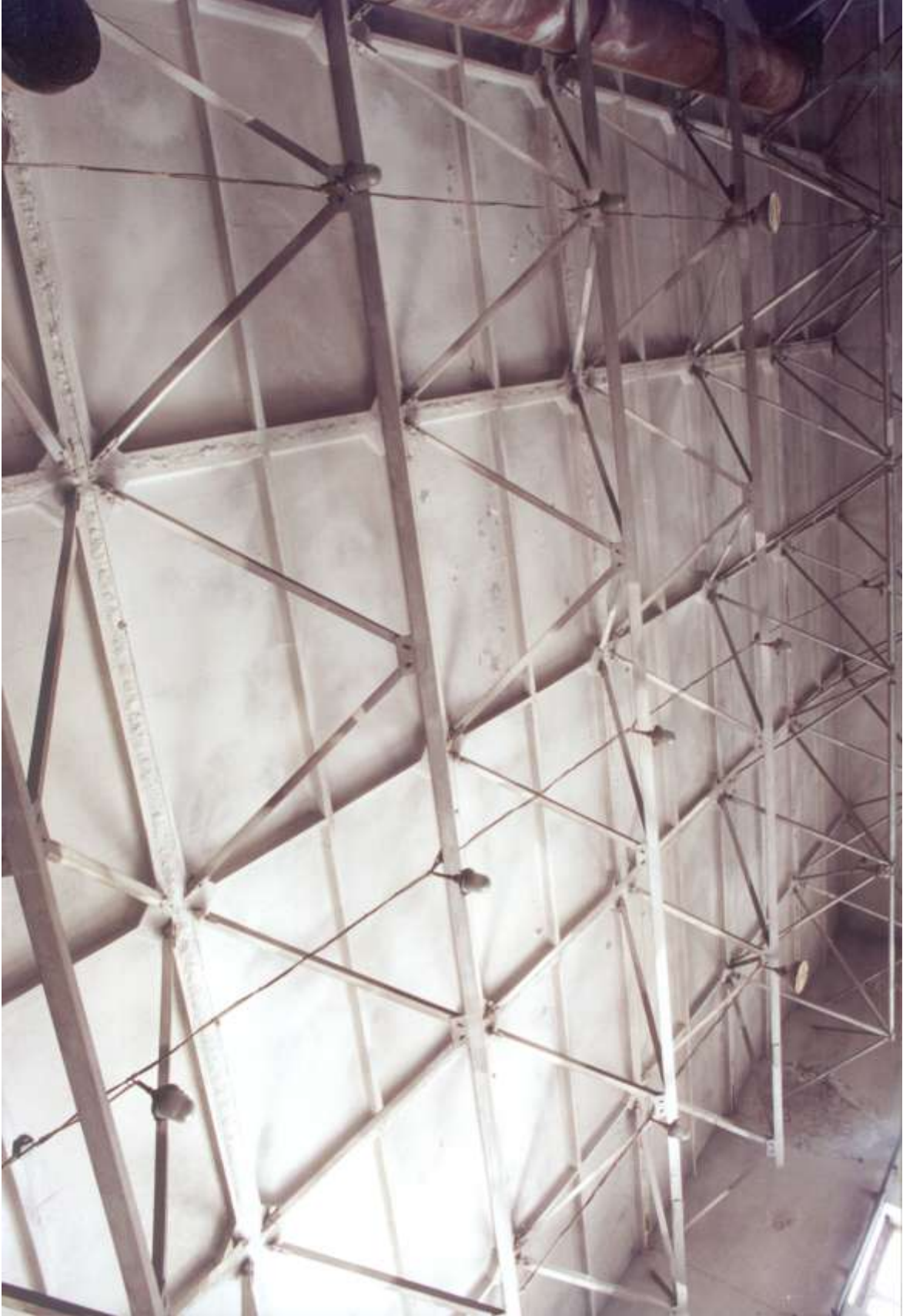
Рис. 4. Фрагмент покрытия гаража КрасГАСА
